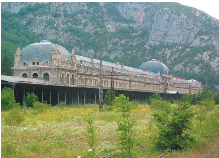
Abbildung 3: Der Bahnhof Canfranc mit seinen gewaltigen Dimensionen wird zur Zeit renoviert und in ein Hotel umgebaut. Der Personenbahnhof wird versetzt. (SUTER, 18.07.2005)
