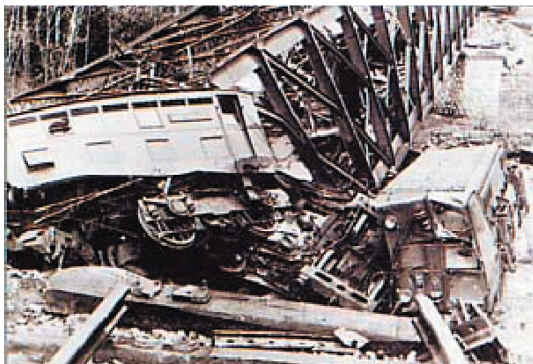
Abbildung 4: Seit dem Unfall am 21. März 1970 auf der Brücke bei l'Estanguet ist die durchgehende Bahnstrecke unterbrochen. ( http://quierzy.club.fr , 28.09.2006)
