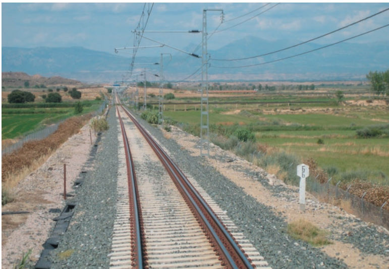
Abbildung 20: Auf dem Abschnitt Tardienta - Huesca ist ein Dreischiengleis eingebaut. Das Normalspurgleis ist elektrifiziert und mit Hochgeschwindigkeit befahrbar. (SUTER, 21.06.2006)
