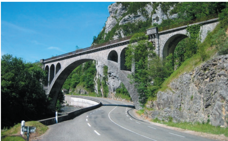
Abbildung 21: Der Viadukt bei Escot. Die Kunstbauten sind weitgehend in gutem Zustand. (SUTER, 24.05.2006)
