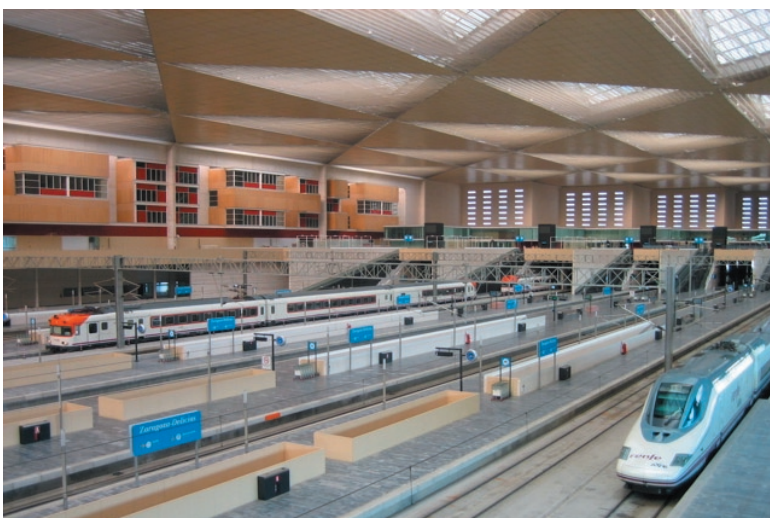
Abbildung 5: Der neue Bahnhof Zaragoza-Delicias als Ausgangspunkt der Canfranc-Strecke für den Personenverkehr (SUTER, 01.07.2006)
