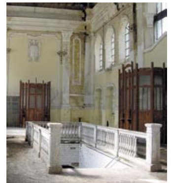
Interior de la estación
